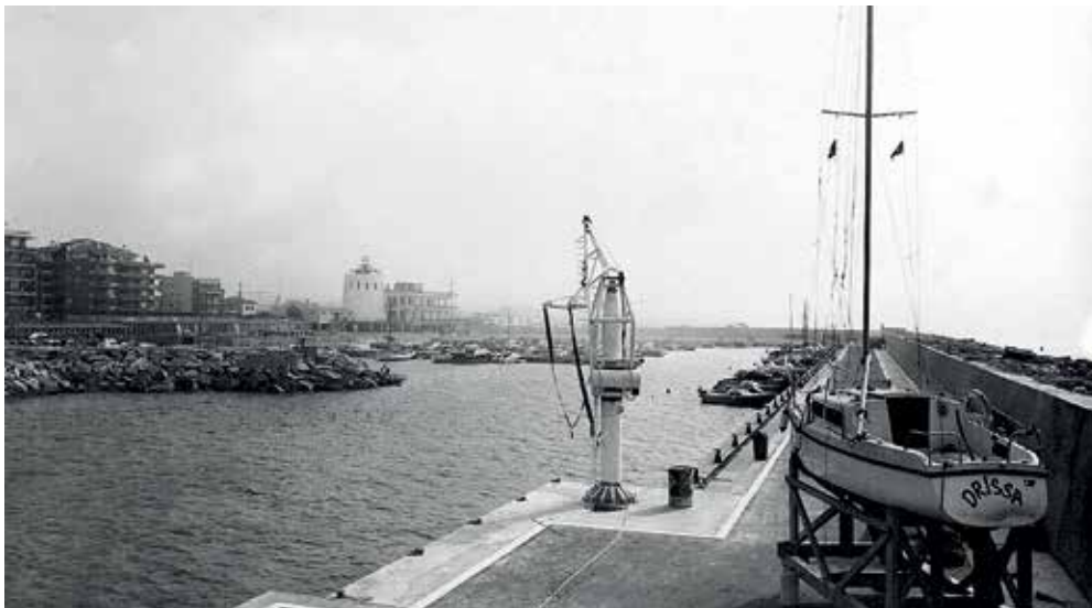
La bocana del primer pequeño puerto no quedaba suficiente separada de la costa y se colmataba de arena con demasiada facilidad
