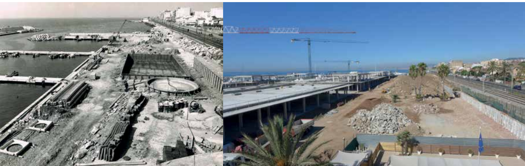
En blanco y negro se ven las obras de la primera casa club, su piscina y del puerto antiguo. Señalar que la playa de Bellamar aun no existía y se creó con los años con los sedimentos de arena a poniente del puerto. En la foto a color con la misma perspectiva, se visualiza que el actual centro comercial se levanta en el antiguo espejo de aguas
